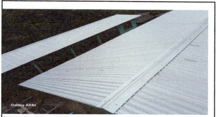
Foto 2: sustitucion de techo de modulos 1 y 2
