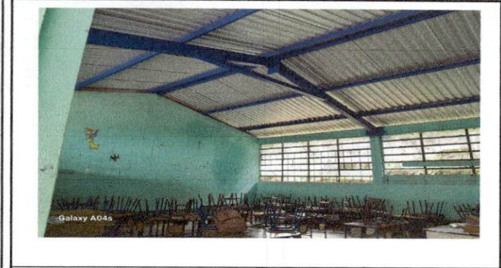
Foto1: sustitución de techo
